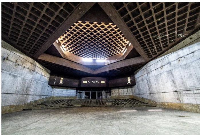
Le curage de la zone culturelle est terminé.
