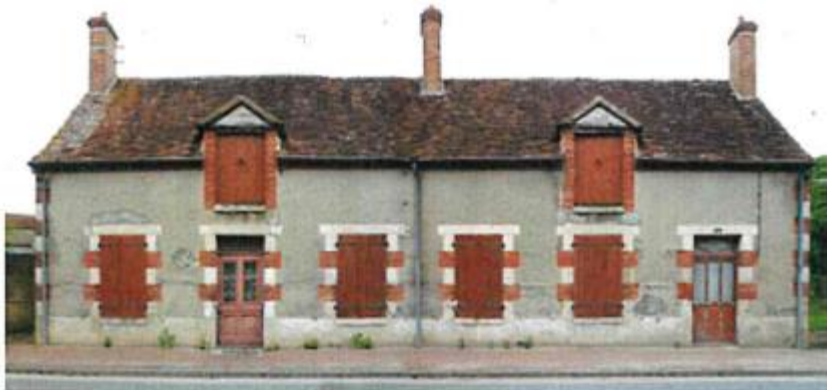
Habiter un bâtiment existant
