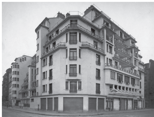
Immeuble et piscine des Amiraux, Henri Sauvage (1873-1932).
