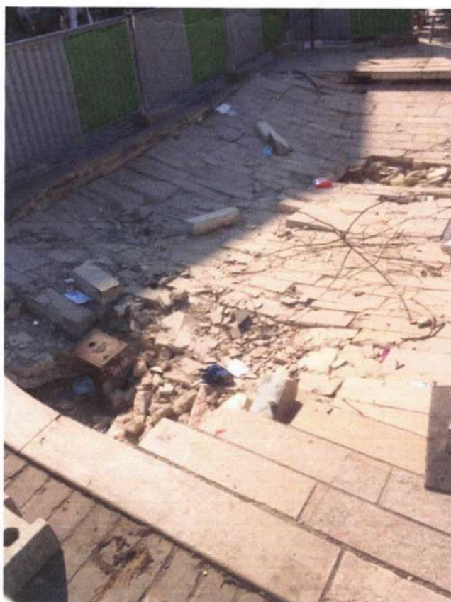
Mars 2022 : Sol effondré sur le parvis de la place P. Séward, réalisé récemment devant l'entrée de la gare du RER de Vincennes.
