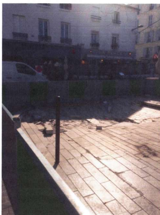
Mars 2022 : Sol effondré sur le parvis de la place P. Séward, réalisé récemment devant l'entrée de la gare du RER de Vincennes.
