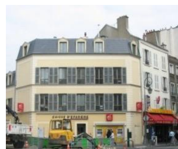
Traitement des angles Avenue du Château
