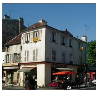
Habitat villageois Rue de Fontenay
