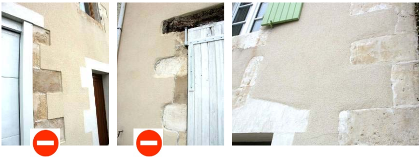
Pose de l'enduit en façade (en coupe)
